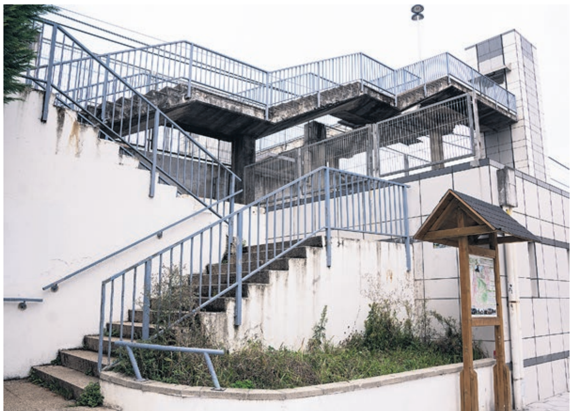
Metro-geltokiaren ondoko eskaileretan ipiniko dute arrapala. OSKAR GUTIERREZ
