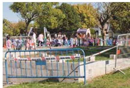
Eraikin aurrefabrikatuak ipiniko dituzte.
