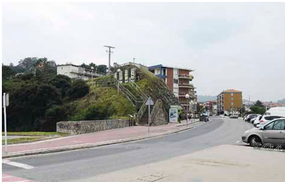
Areatxa kalea asfaltatzeko lanak udal biek ordainduko dituzte.
