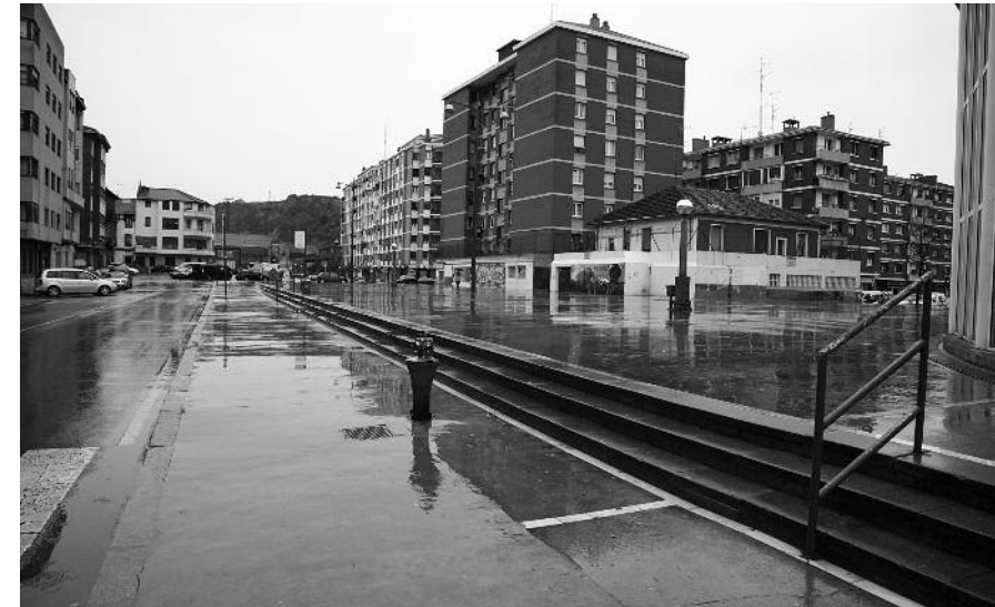
Hormigoizko 16.300 metro koadro inguratzen du Alzagako metro geltokia
